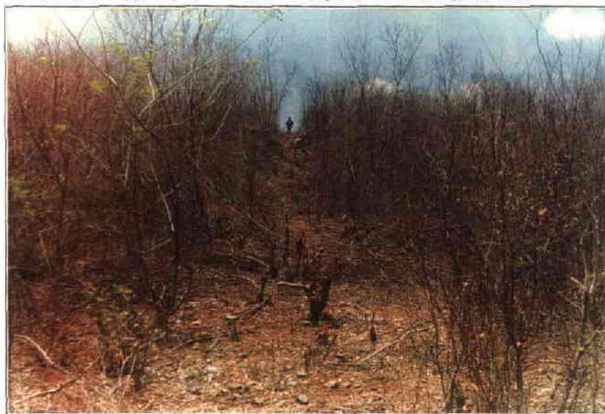
Foto 02 - Detalhe do caminhamento do eixo da adutora de água bruta, mostrando a abertura da faixa de desmatamento para lançamento do estaqueamento, vendo-se ao fundo o local de provável implantação da ETA.
